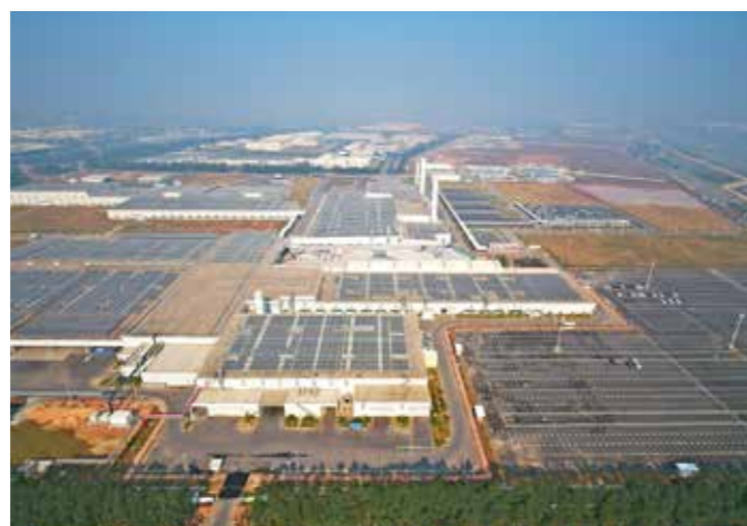
GTMC新工厂全屋顶设置太阳能发电板
